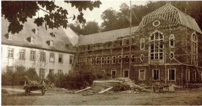
Rohbau der neuen Bibliothek (1908)
