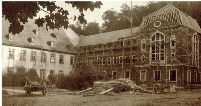
Rohbau der neuen Bibliothek (1908)
